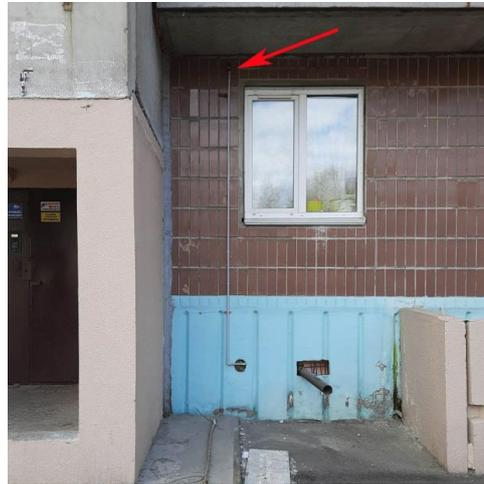
Рис. 3. Датчик наружной температуры (ул. Киевская, 26)
